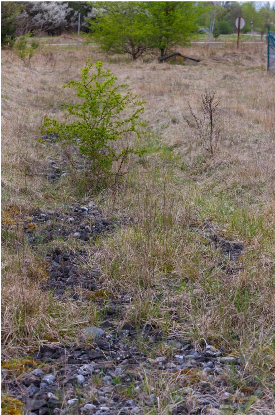
Abbildung 3-63: Gleisschotter als Überrest der früheren Gleistrasse
