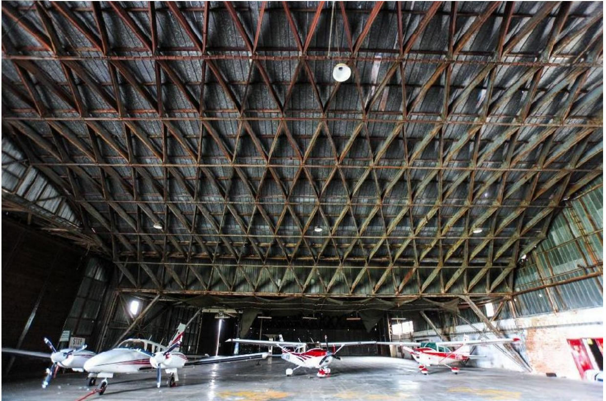
Abbildung 30: Junkers Hallen ermöglichten den einfachen Transport und Aufbau auch in entlegenen Gebieten Diese westliche Halle wird von 5 fliegenden Vereinen zur Unterstellung der Segel- und Motorflugzeuge verwendet.
